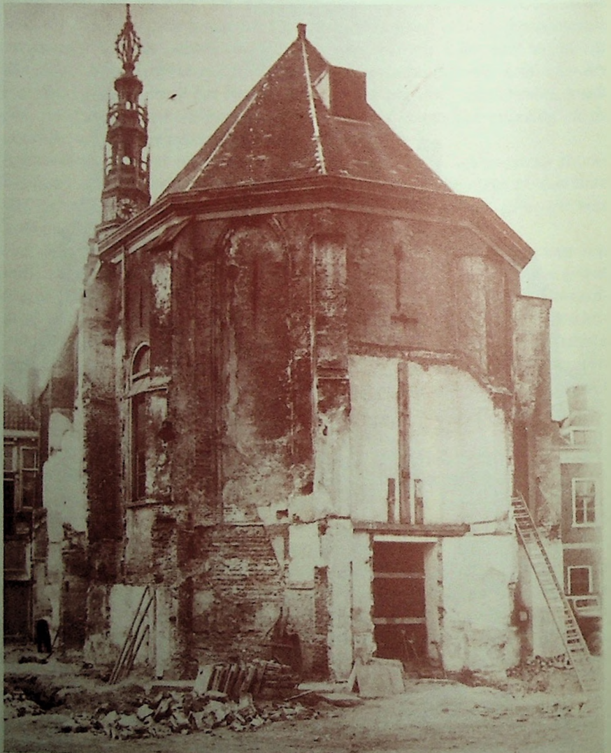
zicht op het koor tijdens het sloopwerk.
