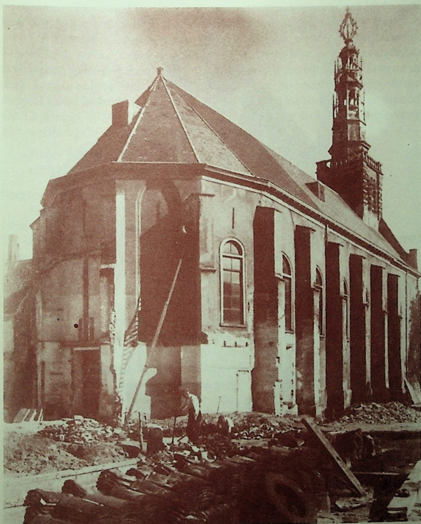
Sloopwerkzaamheden rond de Lodewijkskerk i.v.m. de verbouwingsplannen van 1956.
